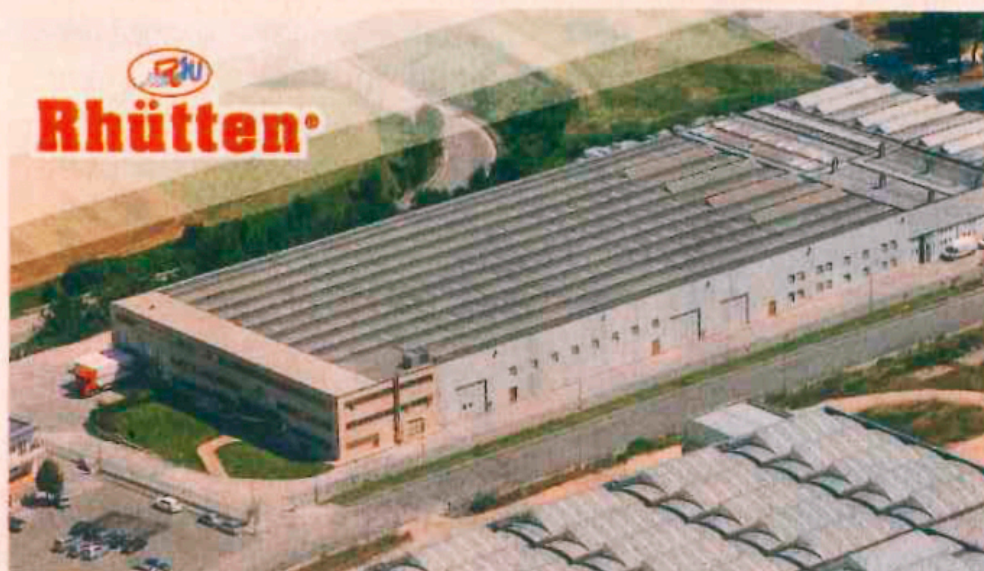
Panoramica dello stabilimento
